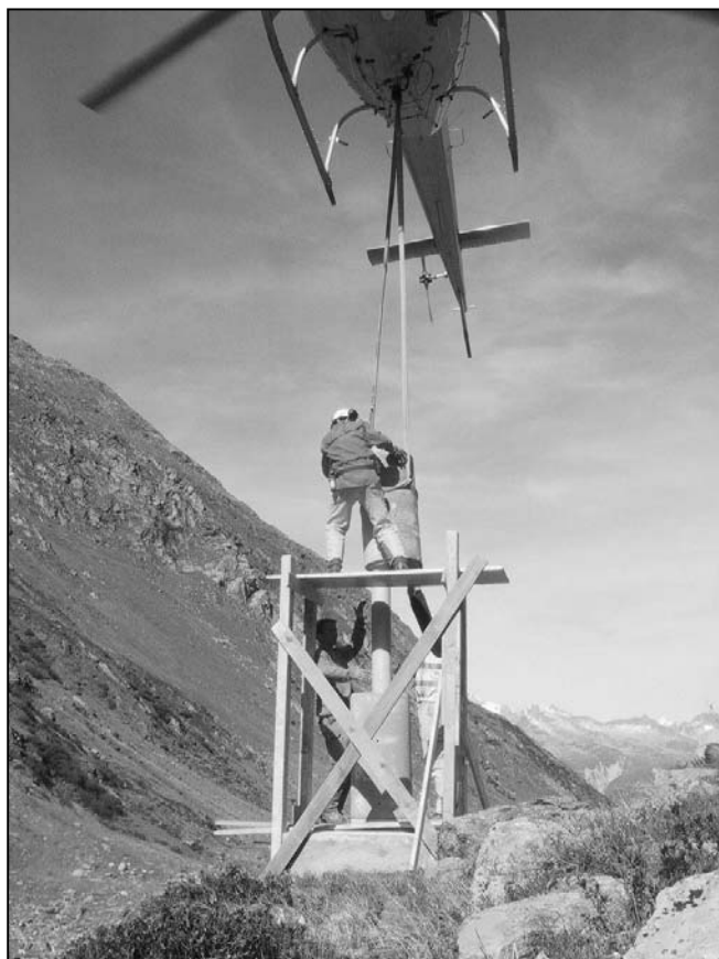
Abb 7: Helikoptereinsatz beim Pfeilerbau
