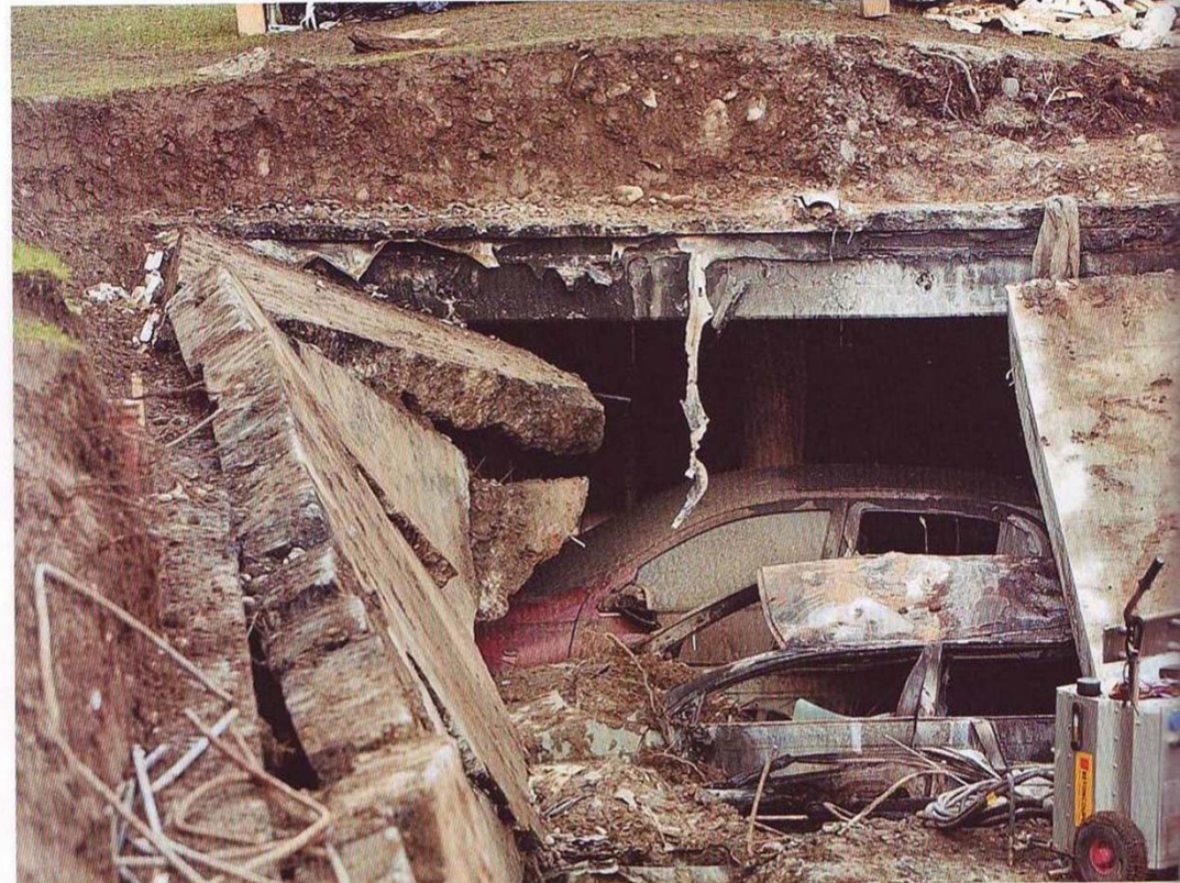
Einsturz einer Tiefgarage während eines Brandes in Gretzenbach SO 2004.
