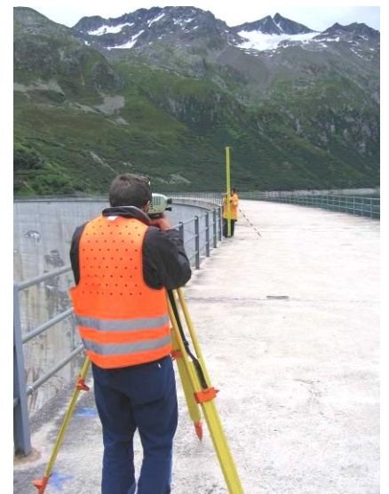
Abb. 6.21 Nivellement an einer Staumauer
